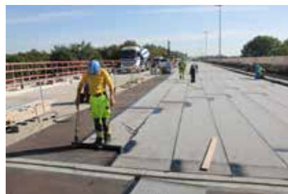
Figuur 60: Renovatie werkzaamheden viaduct
