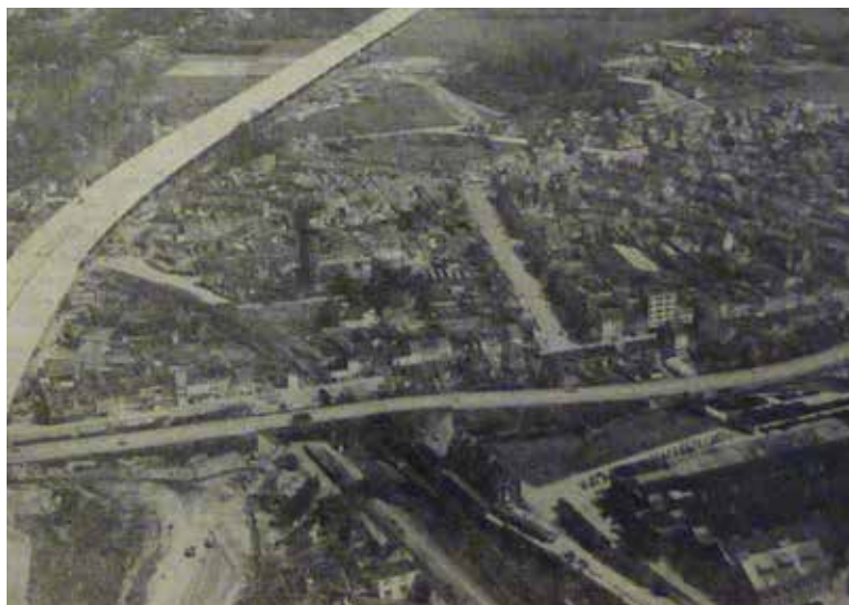
Foto uit Krantenartikel met de kop: "De bouw van de viadukt te Gentbrugge (1.600 m. lang) - een spectaculair geval.
